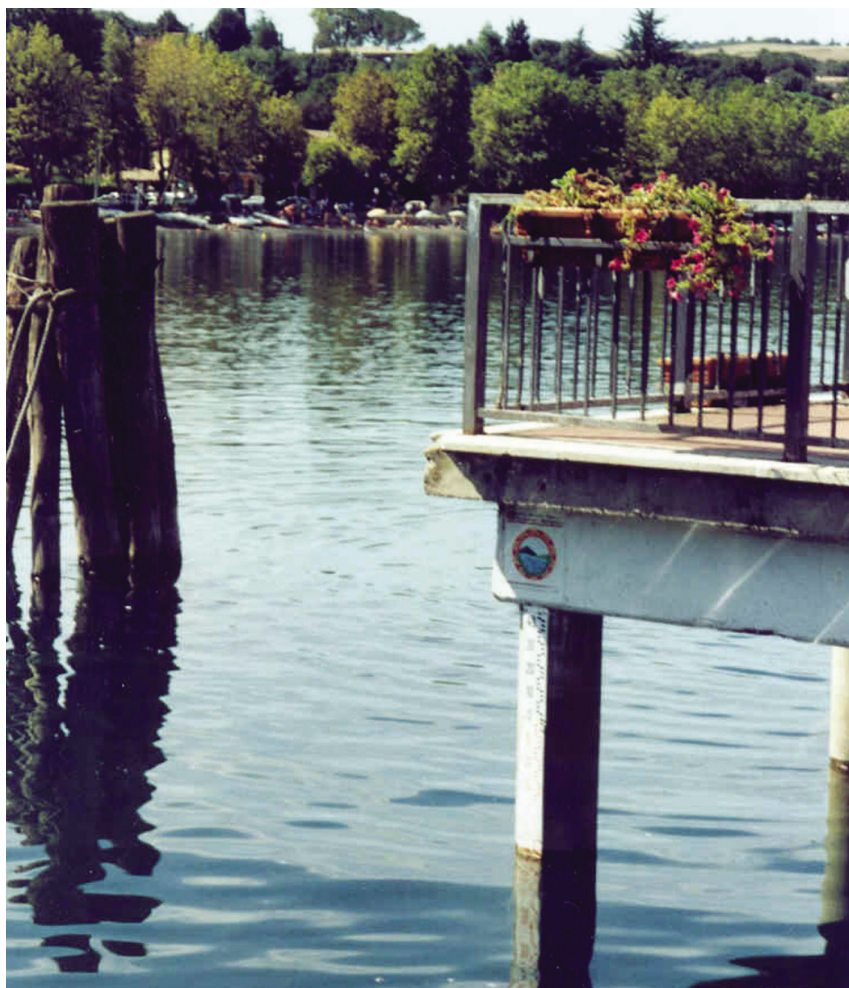
Figura 3 - Lago di Bracciano (2006), particolare molo di Trevignano. Lo zero idrometrico è a metà del pilastro di sostegno [livello attuale - 60 cm circa]
