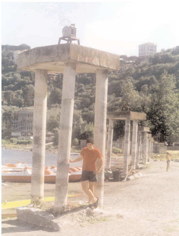
Figura 5 - Lago Albano (2005), particolare. Lo zero idrometrico è sotto la piastra in cemento armato in alto [livello attuale - 450 cm circa].
