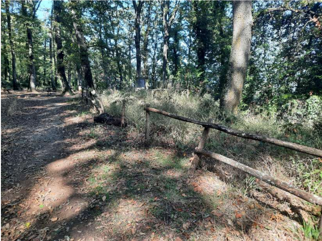
Recinzione oggetto di manutenzione.
