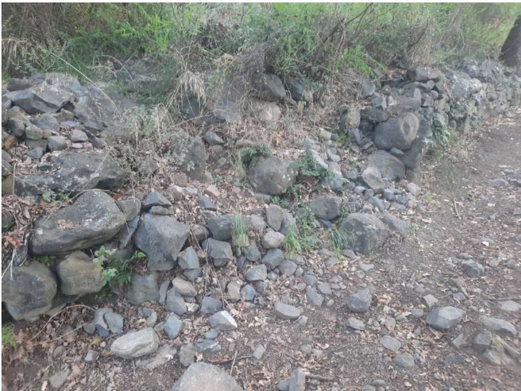
Muro a secco oggetto di manutenzione.
