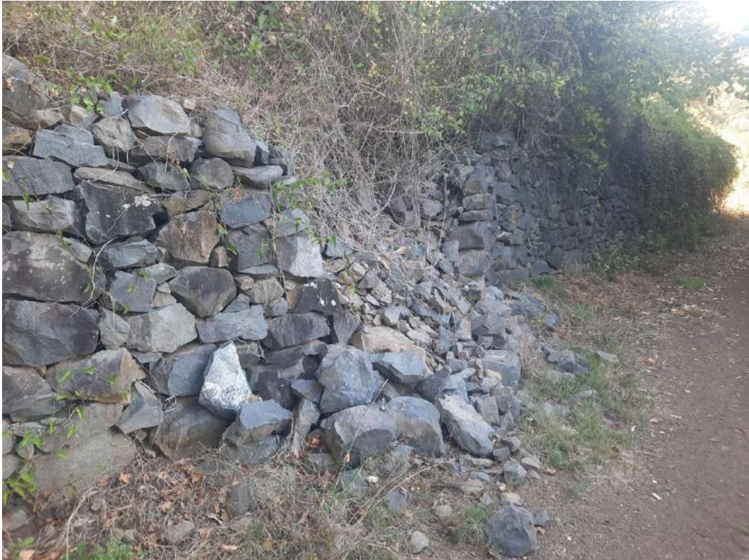
Muro a secco oggetto di manutenzione.
