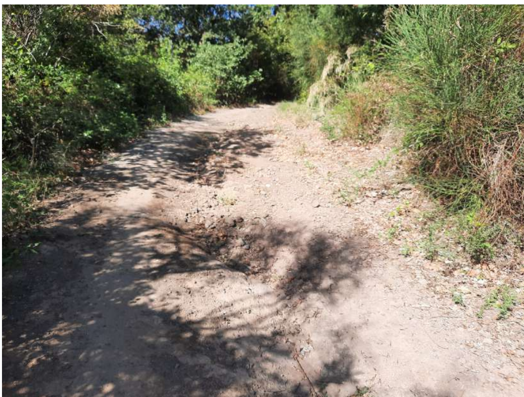
Tratto di viabilità da sottoporre a manutenzione.
